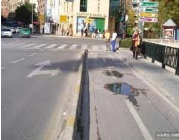
Separación rígida – Bordillo
